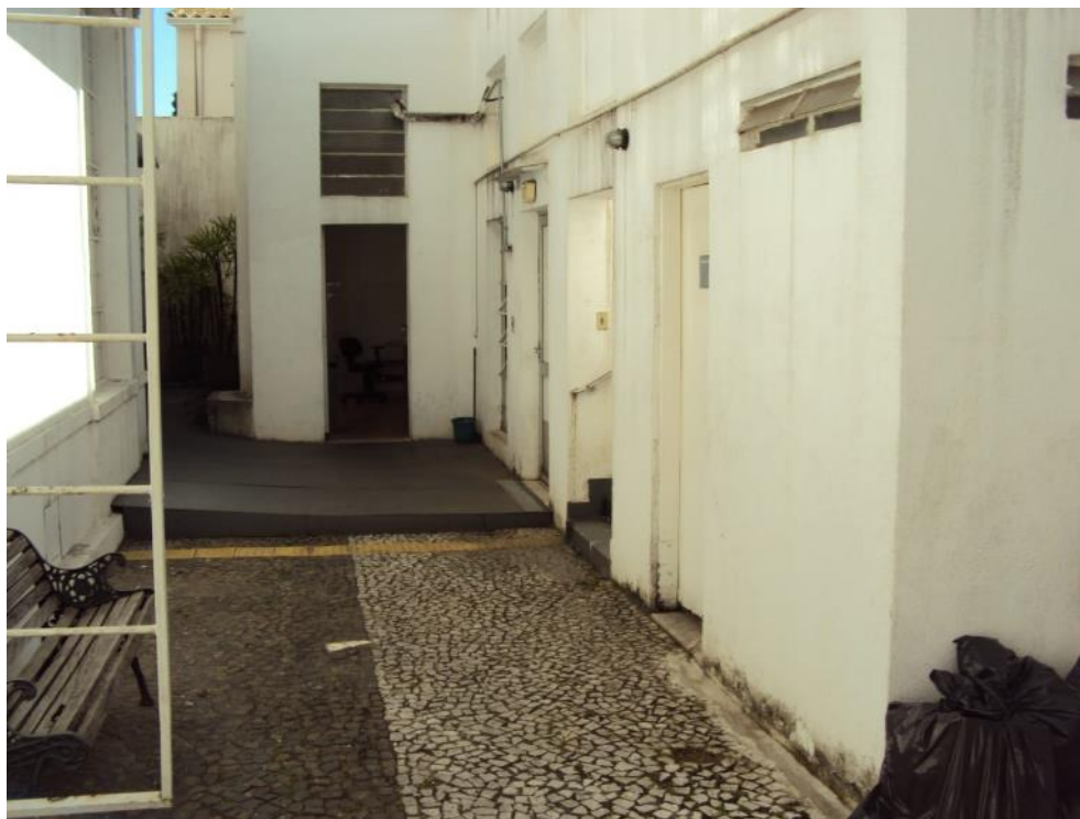
Foto 17 – Edícula – Aspecto geral.
