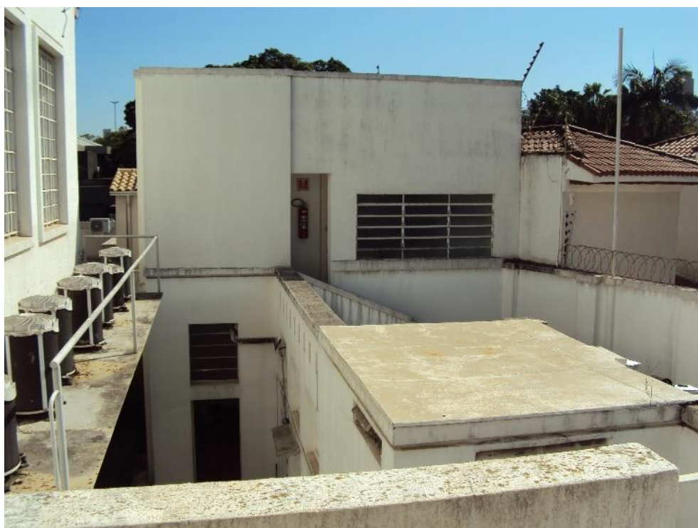
Foto 20 – Edícula – Aspecto geral.
