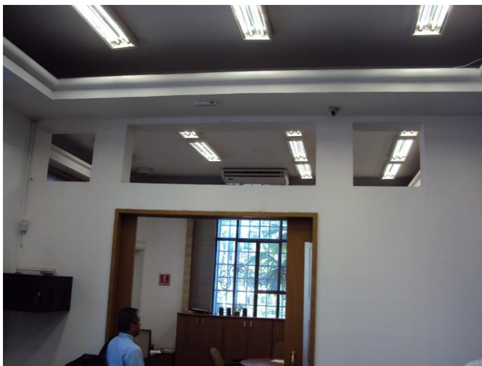
Foto 16 – Corpo principal – Pavimento superior – Sala da gerência.
