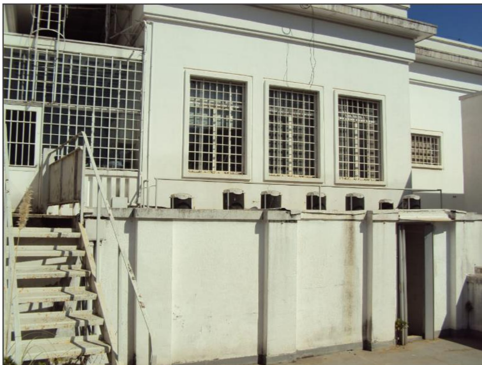
Foto 21 – Vista externa da construção – corpo principal.
