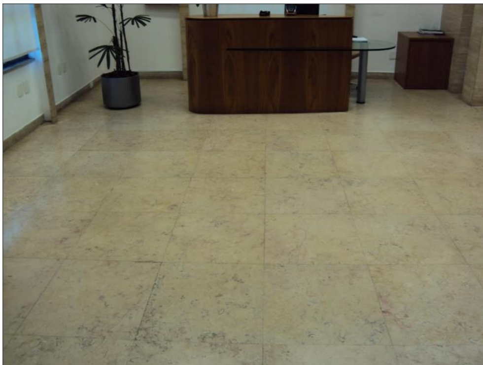
Foto 9 – Corpo principal – Pavimento térreo – Recepção (Detalhe do acabamento)
