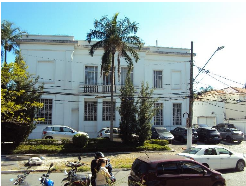
Foto 2 – Vista do imóvel à partir da Rua Argentina.
