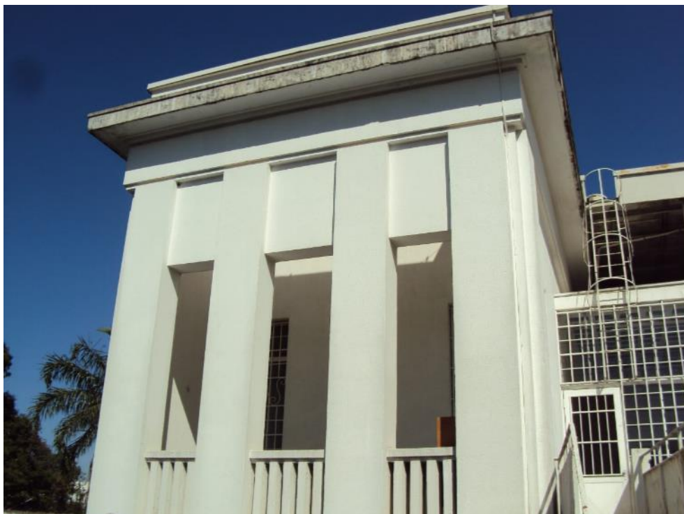
Foto 22 – Vista externa da construção – corpo principal.
