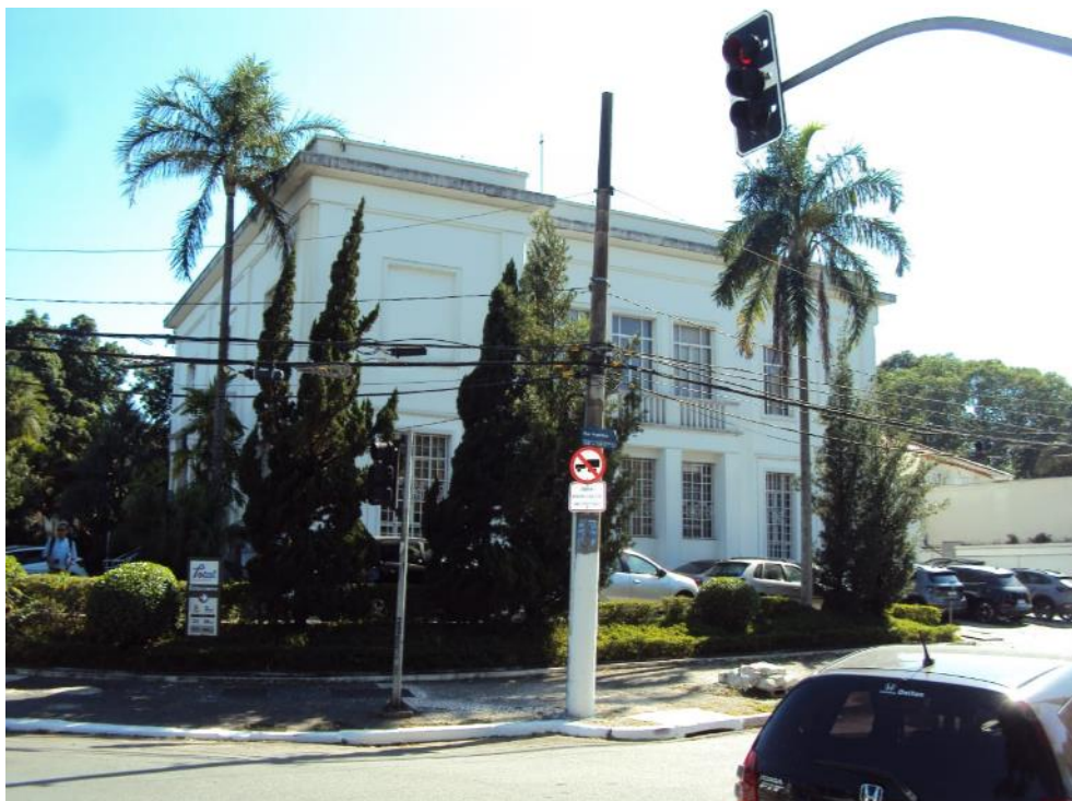
Foto 5 – Aspecto geral da construção.
