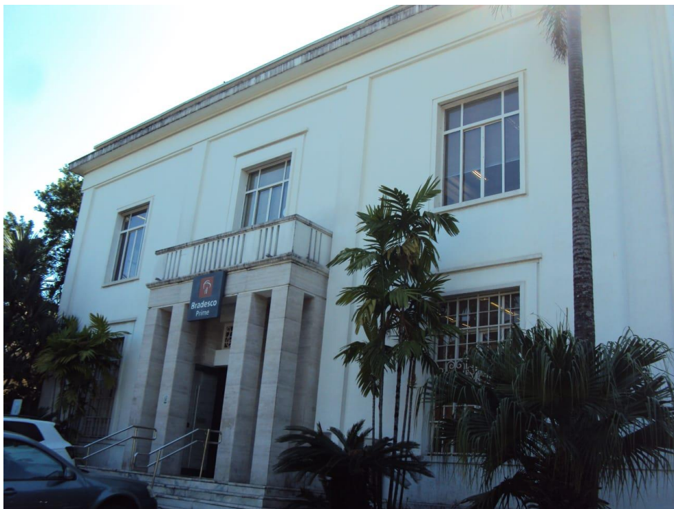
Foto 3 – Vista da entrada principal – Av. Brasil, nº 1122 – Banco BRADESCO PRIME.
