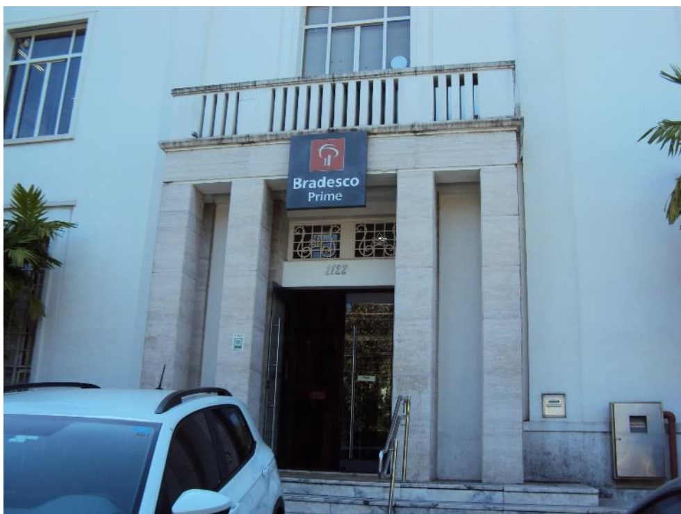
Foto 4 – Aspecto geral da construção.
