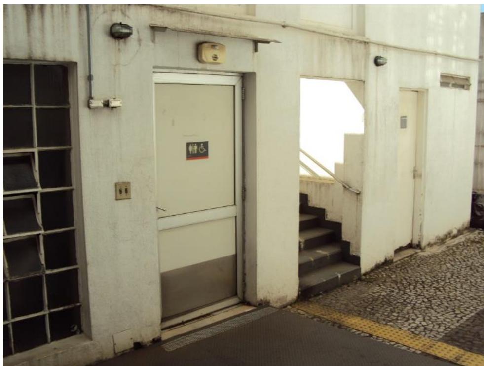
Foto 18 – Edícula – Detalhe da construção.
