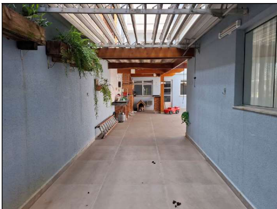
Vista da cobertura.
