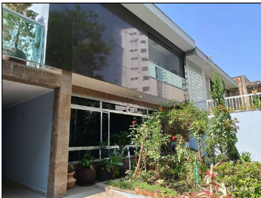
Vista da Fachada da construção principal.
