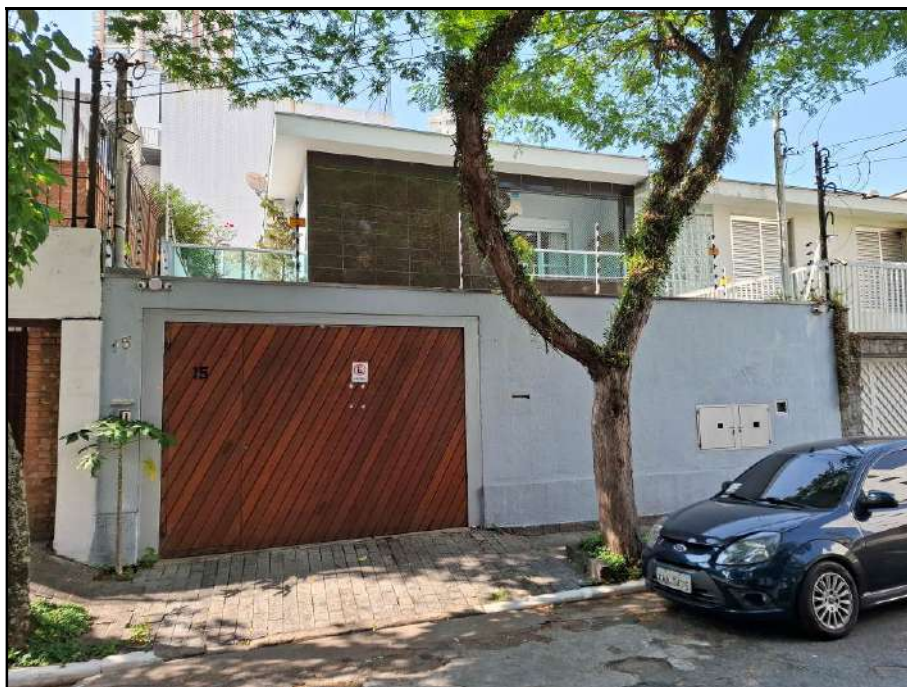
Vista da fachada principal do imóvel avaliando.
