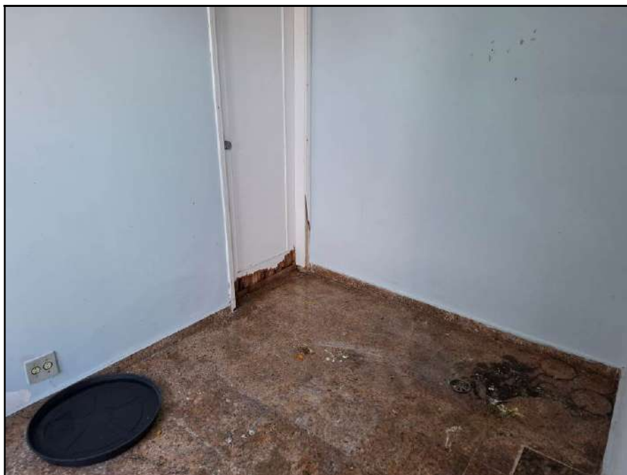
Vista do dormitório.
