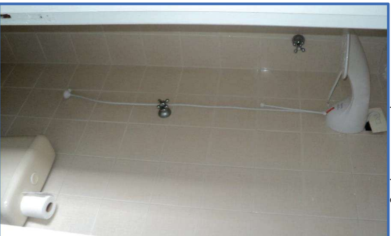
Foto: visão do banheiro de empregada.
