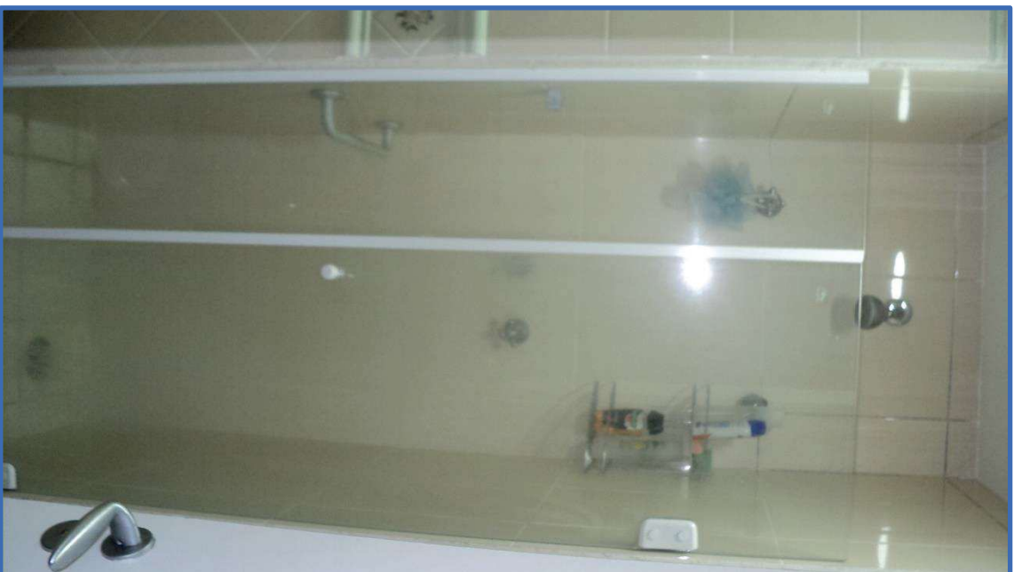
Foto: Visão do banheiro do corredor.
