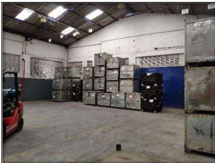
Foto 25 – Vista geral de um dos galpões que integram o complexo industrial.
