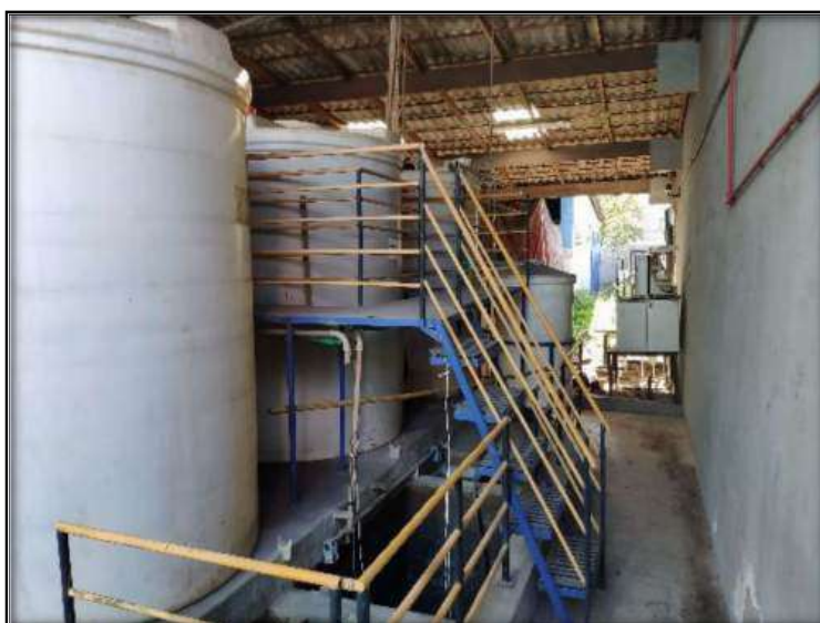
Foto 20 – Vista geral de outro galpão.
