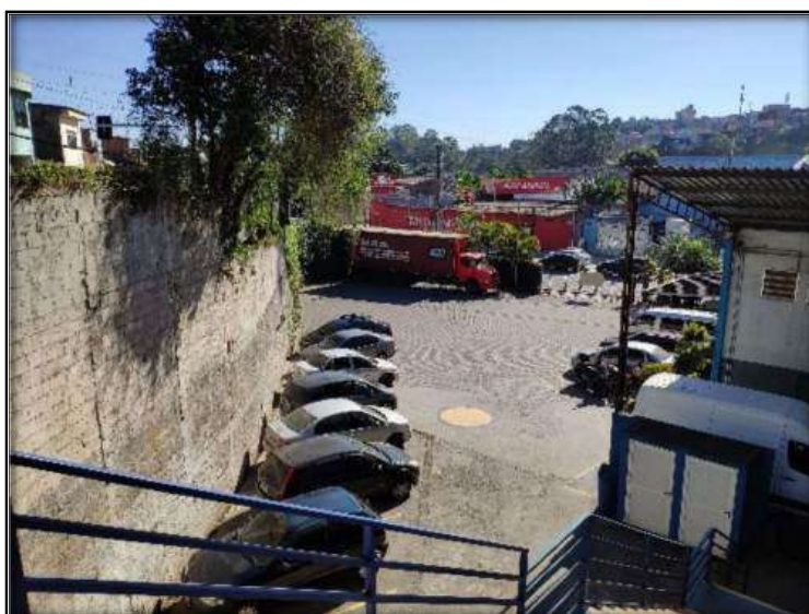
Foto 4 – Vista geral do pátio do complexo industrial.
