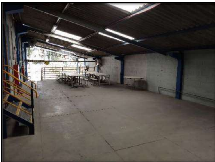
Foto 37 – Vista de uma área de lazer, adjacente ao galpão ilustrado na fotografia anterior.
