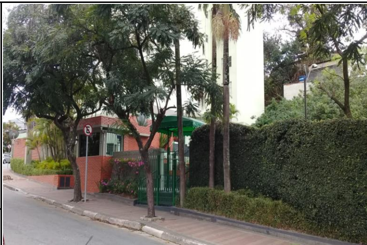
Foto da Fachada do Imóvel
