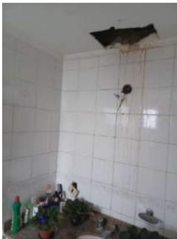
Foto 11: Banheiro 3ª suíte
