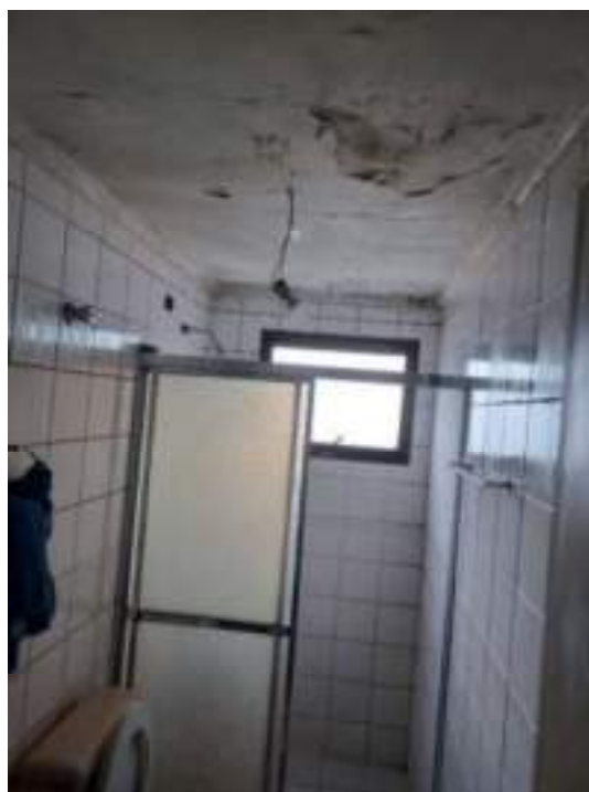
Foto 7: Banheiro 1ª suíte
