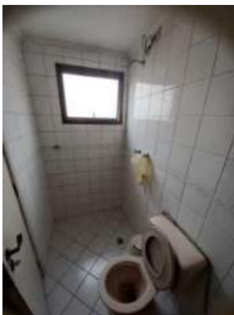
Foto 12: Banheiro 3ª suíte
