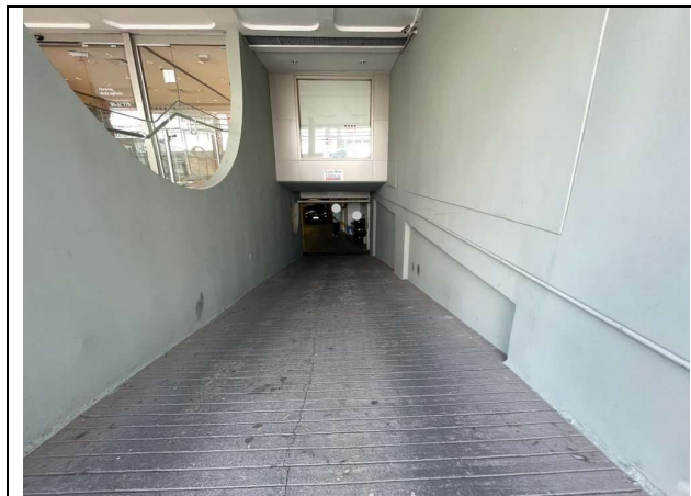
Vista do acesso ao estacionamento do imóvel em estudo – Subsolo.
