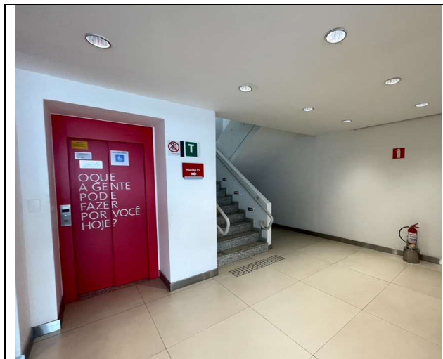
Vista do acesso ao 2º pavimento.
