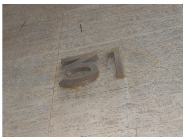
Vista parcial de placa de identificação numérica do imóvel em estudo
