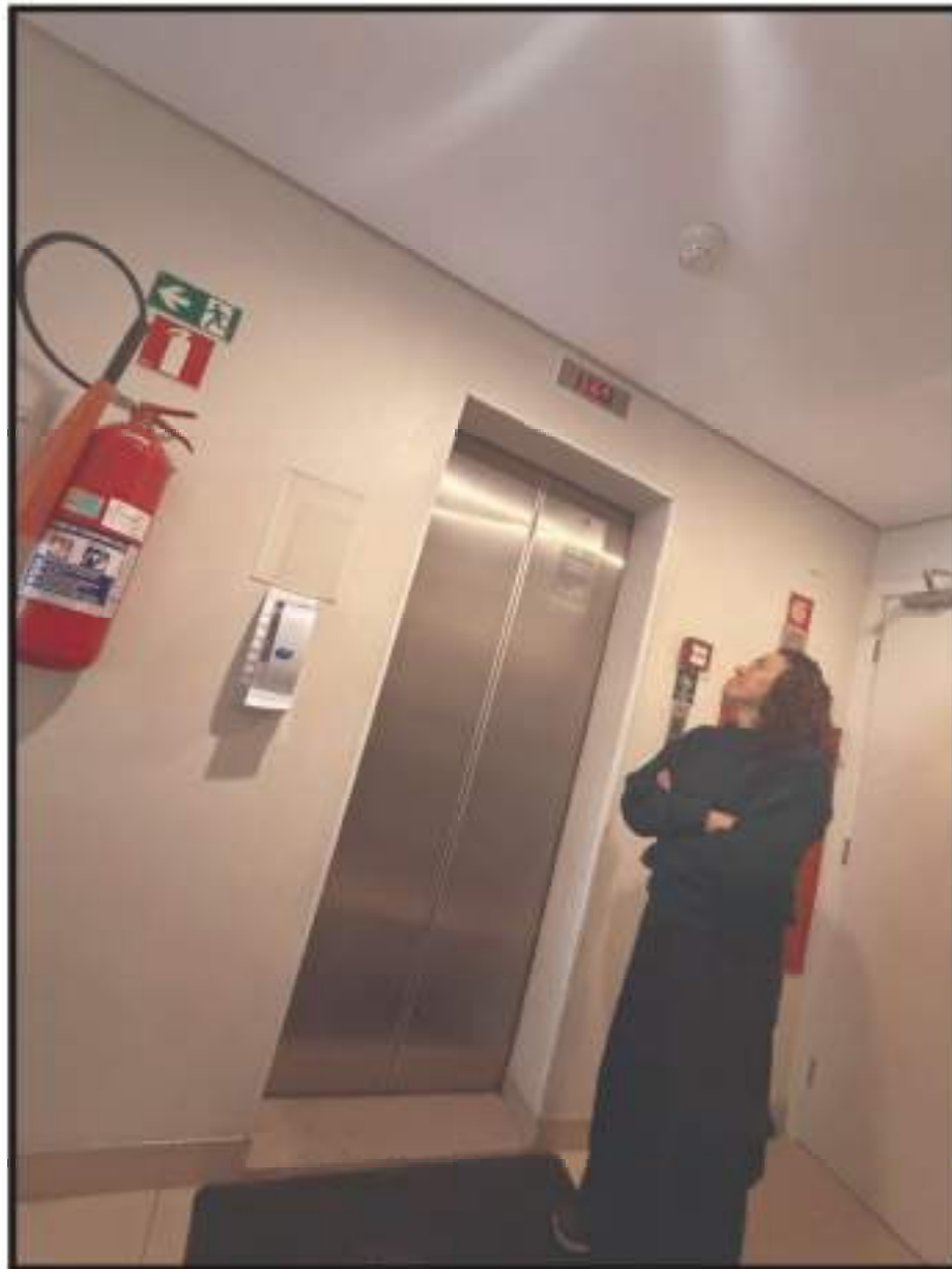
Foto nº 11 – Ilustra porta de entrada para um dos elevadores que servem o edifício.
