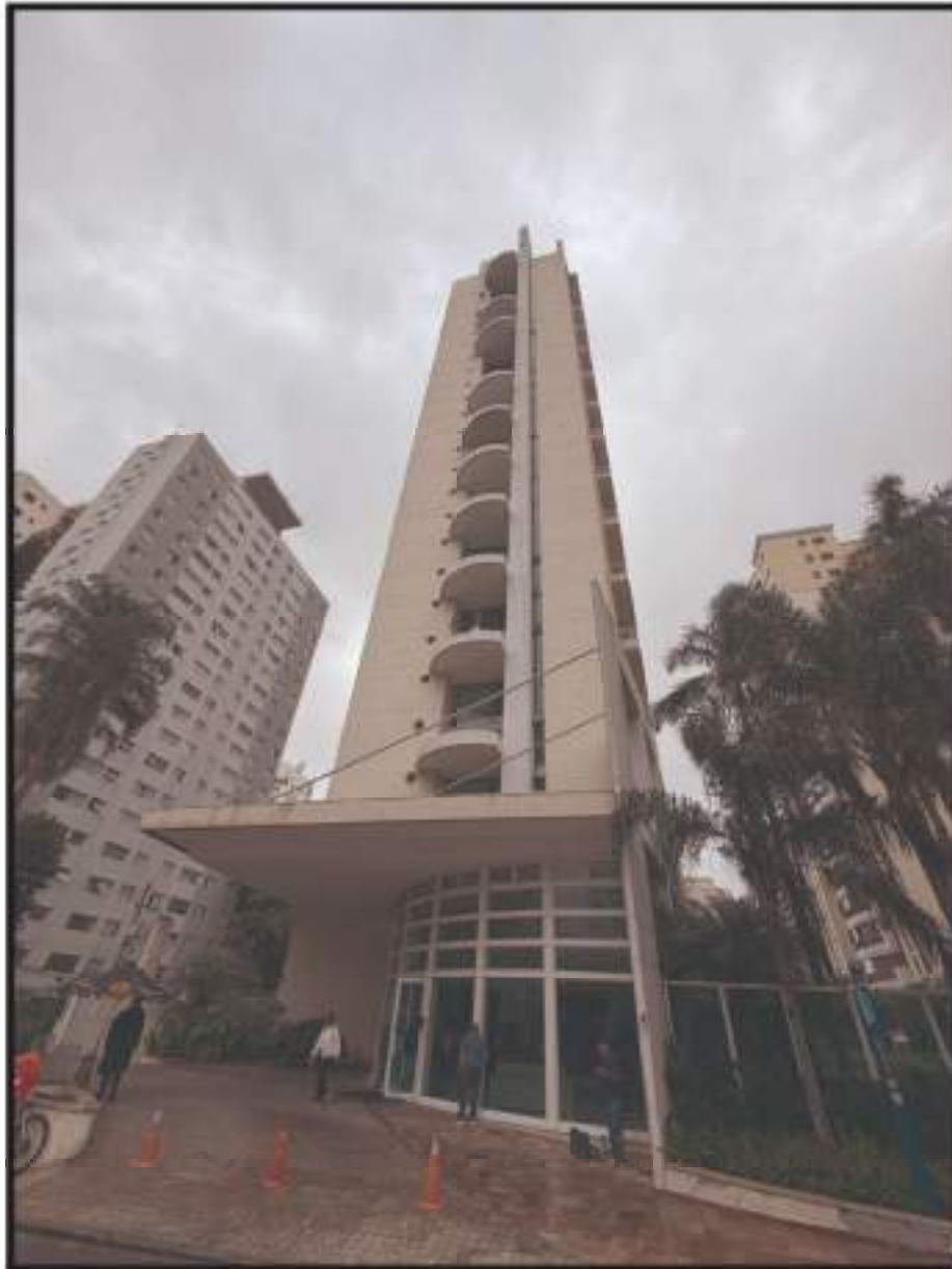
Foto nº 02 – Vista da fachada do edifício voltada para Rua Diogo Jacome.
