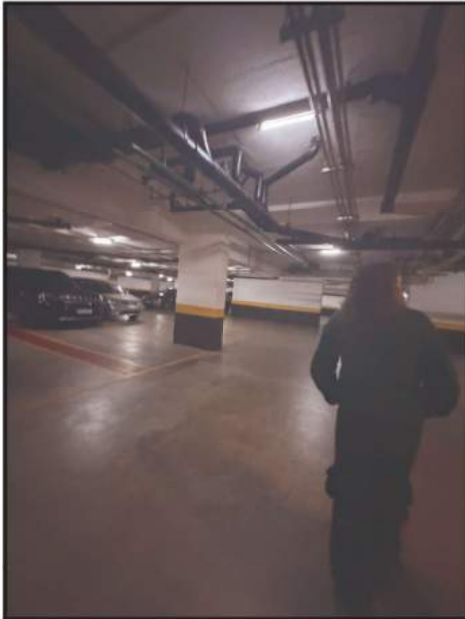
Foto nº 37 – Vista parcial do subsolo de garagem.
