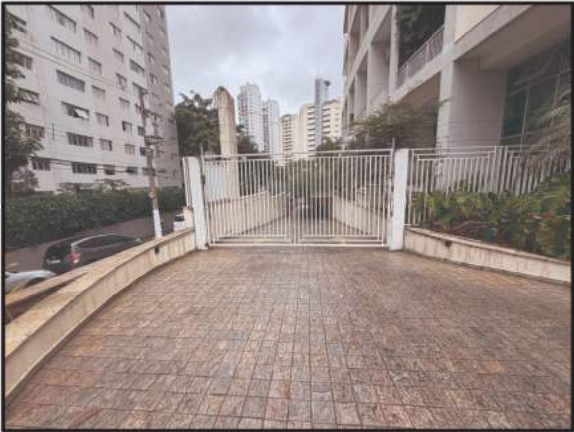
Foto nº 05 - Ilustra o portão de acesso aos subsolos de garagem, destinado aos veículos.
