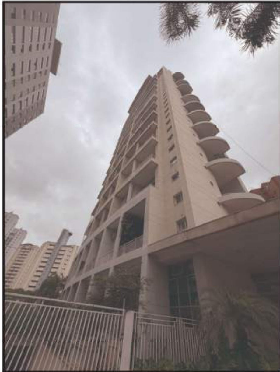
Foto nº 04 – Vista da fachada lateral voltada para a Rua Indiaroba.
