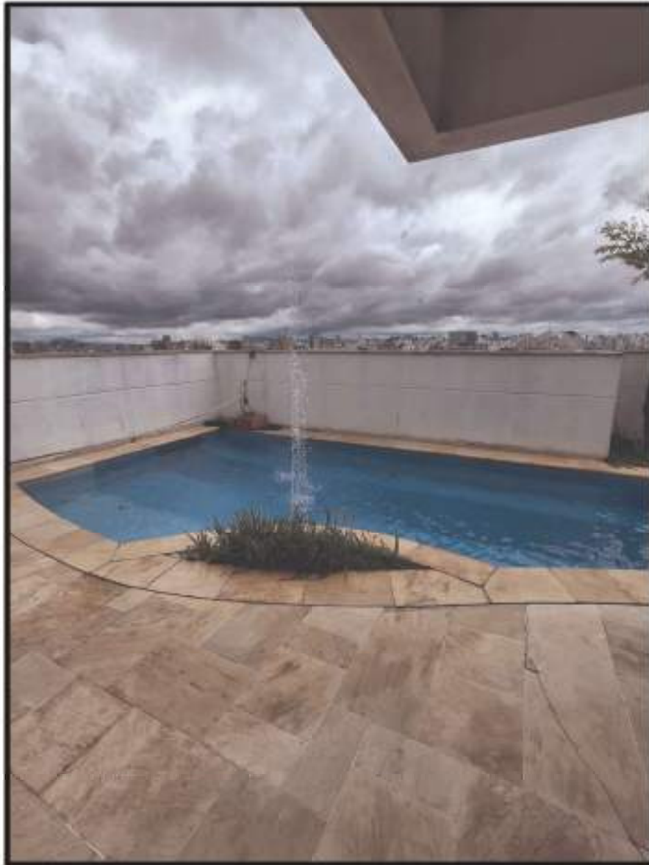
Foto nº 34 – Ilustra piscina existente na cobertura do edifício.
