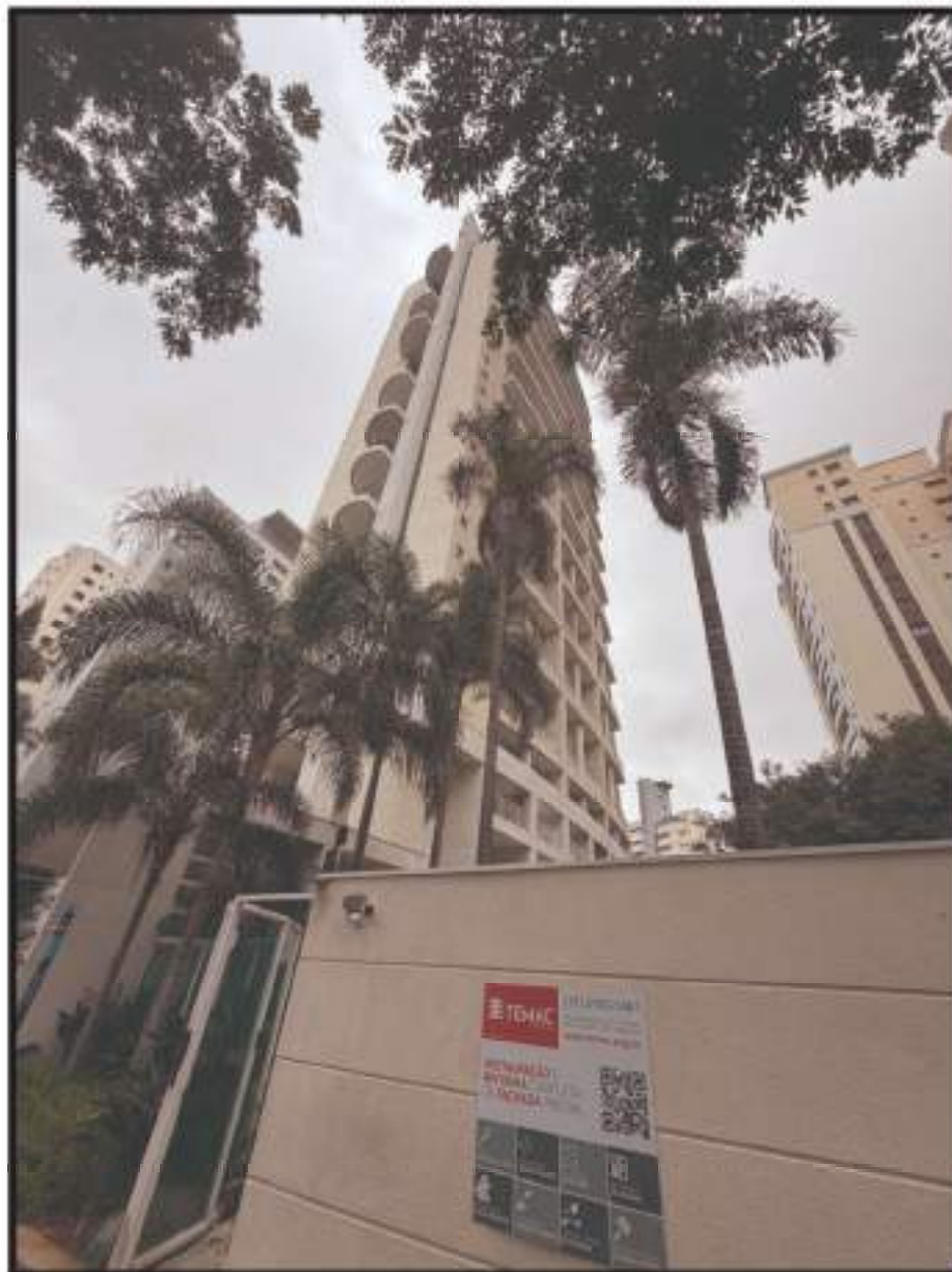
Foto nº 03 – Vista da fachada lateral do edifício, observada a partir da Rua Diogo Jacome.
