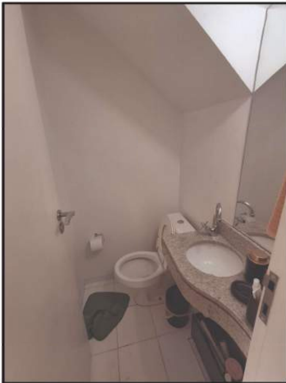
Foto nº 16 – Aspecto interno do lavabo.
